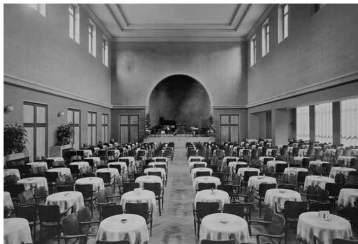
Der Festsaal nach dem Umbau 1932. (Architekt: Lebrecht Völki)
